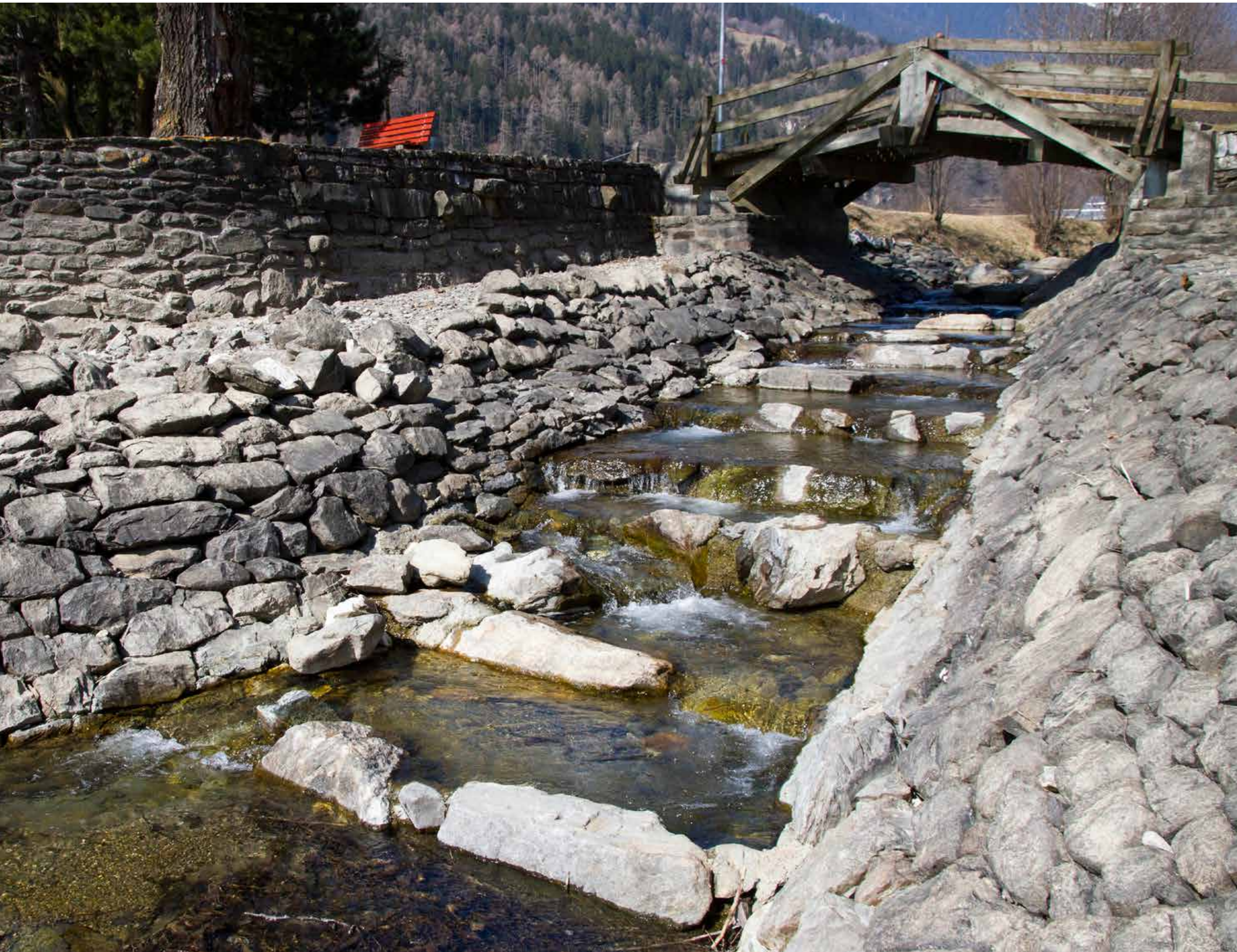
Rampa di risalita. Blockrampe.
